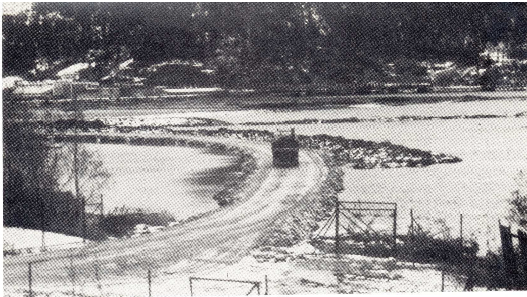
Fra anleggsområdet på Sandfærhus, oktober 1993. Foto: Per Inge Værnesbranden.
