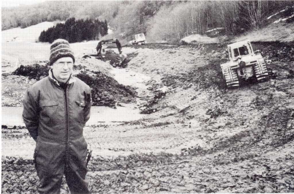
Grunneier og initiativtaker Jens Loddgard ved utgravingen av Loddtjønna våren 1995. Foto: Harald Langås, Trønderbladet.
