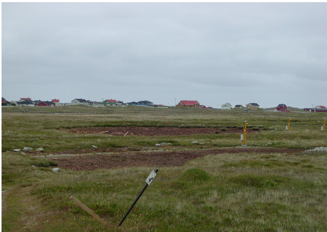
Ved enden av flystripa. Montering av lufthavnas innflygingslys er gjort på en slik måte at området er drenert ut. Vi ser skiltingen av naturreservatet i forgrunn.
