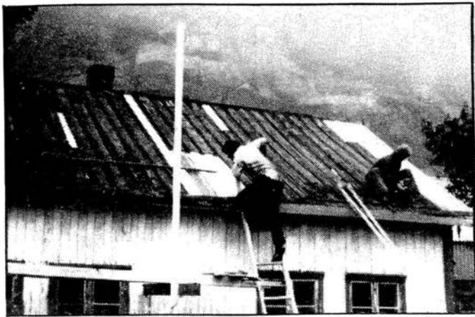
Fra "den store takreparasjonen" i august 1977. Lars i stien og Kurt på taket.
