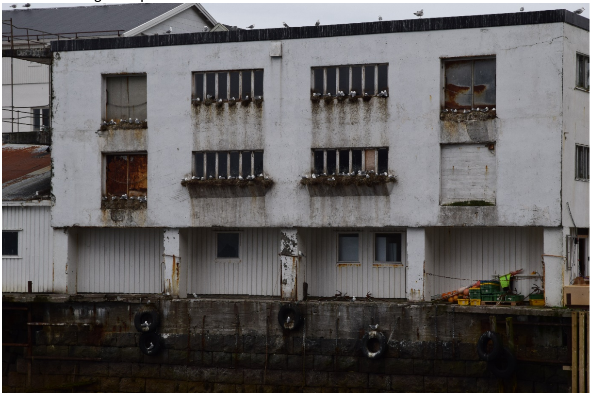
Å. Reir på bygning og kai.
