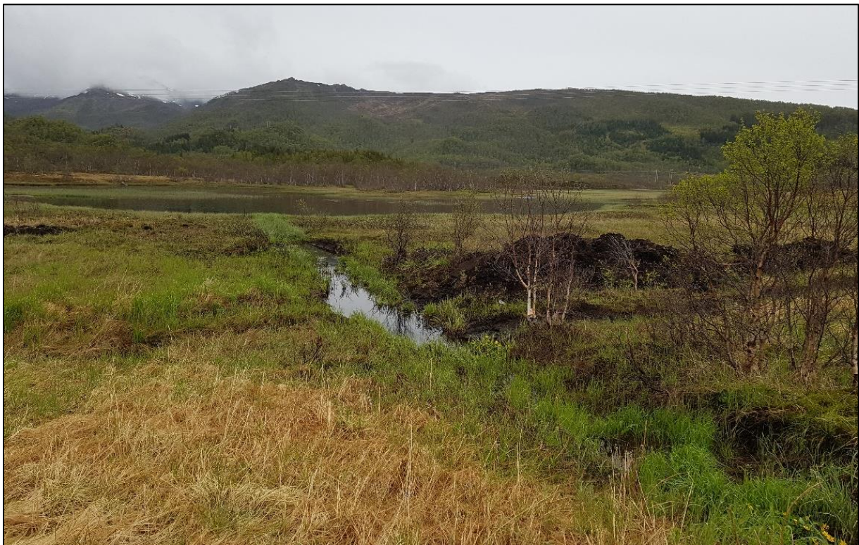
Dreneringsarbeid i forbindelse med nydyrking av myr rundt Straumvatnet i Sortland. Foto: Martin Eggen
