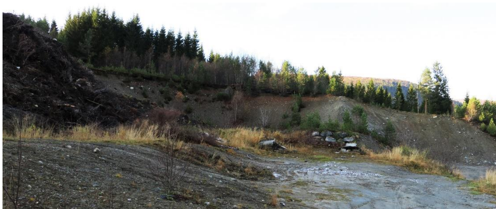
Svineryggen i 2019. Det finnes nesten ingen loddrette partier i sandfasaden. Til venstre i bildet vises utfyllinga med overskuddsmasser som er påbegynt.
