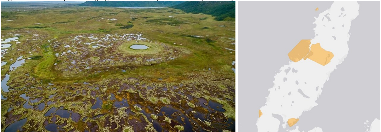
Fig. 2. T.v.: Deler av planområdet på Andmyran. T. h.: Deler av Andøya med Emerald Network-området Skogvoll avmerket på midtre del. Andmyran vindkraftverk er konsesjonsnett og under behandling for forlenget konsesjon i de vidstrakte myrområdene like nordøst for «smaragd-området». Foto: Espen Bergersen.
