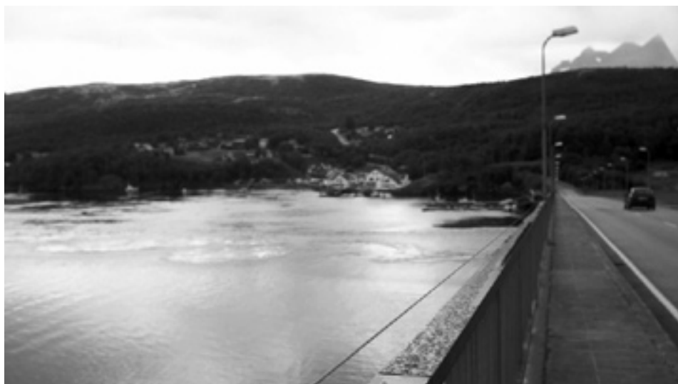
Streng over rekkverk på Indre Sunnan bro, broa nedover mot laveste punkt mot Tuvsida som er mest utsatte punkt for fuglene.
