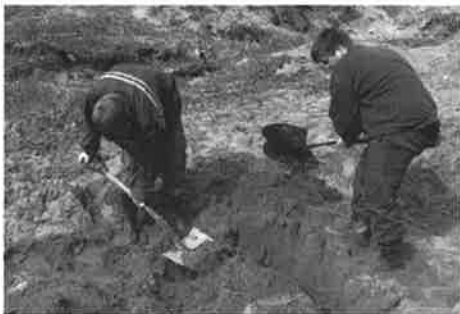
De første spadetakene tas i slutten av april. Elever fra Korgen Sentralskole graver fundamentet for Leca-veggen som skal reises. Foto: Ole-Ivar Øverleir.
