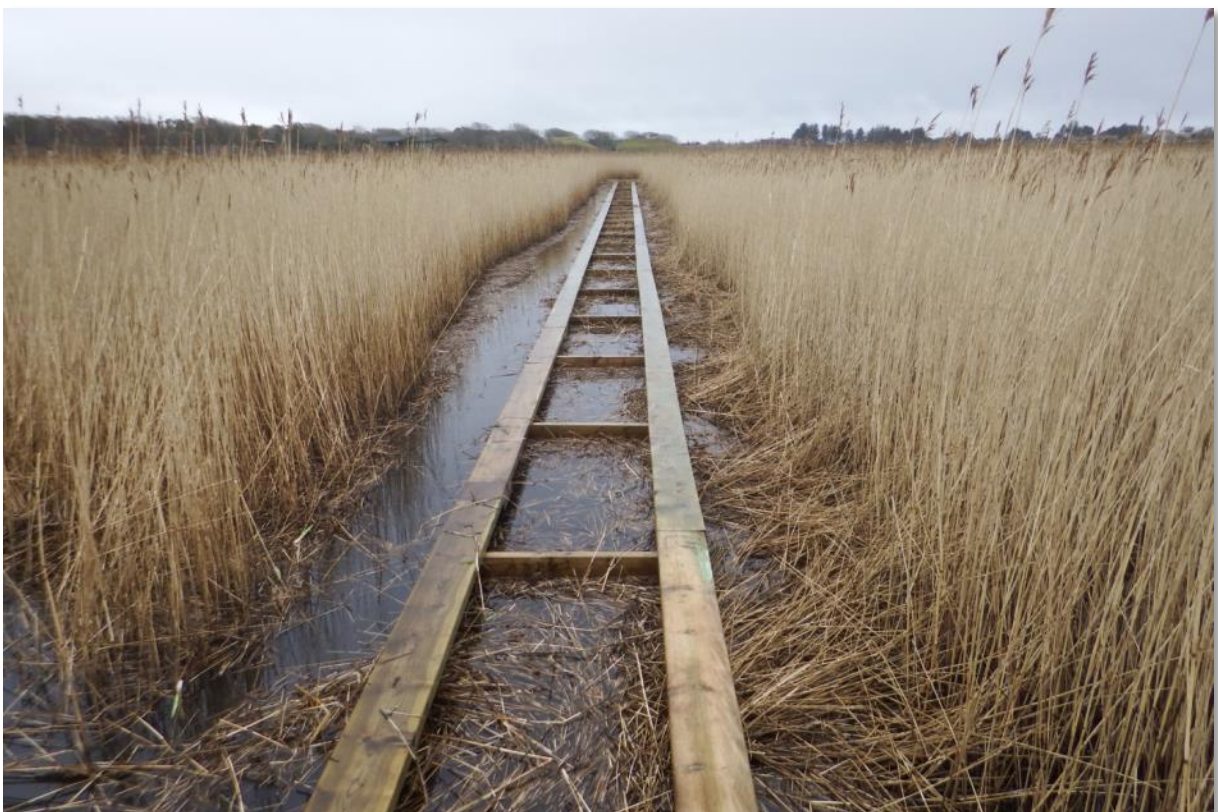
Nettgaten med plankestier på begge sider, like etter ferdigstillingen den 2. mars 2017 © Knut Olsen
