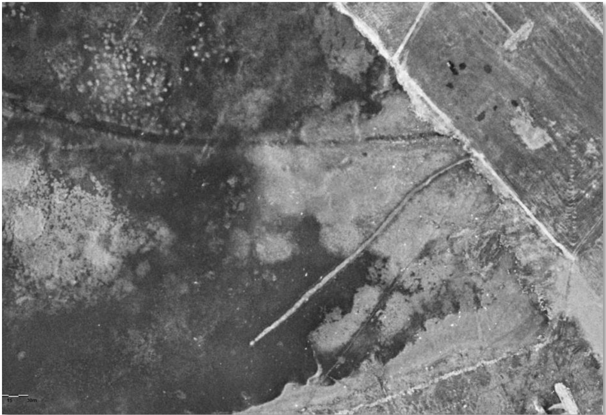
Flyfoto av den nordøstlige delen av Slevdalsvann den 28. juni 1956, før «Ammoveien» ble anlagt». Oppe i høyre hjørne sees fyllingen for den fremtidige rullebanen som også ble fylt ut i Slevdalsvannet. © norgebilder.no
