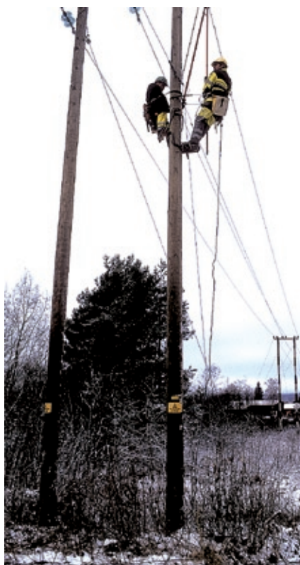
Montører fra Ringeriks-Kraft tar ned høyspentledninger nær Storelva på området til Helgelandsmoen militærleir den 24.11. 2003. Foto: Viggo Ree.
